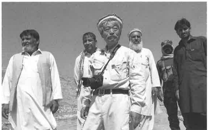
職員たちと工事現場を見回る中村医師
