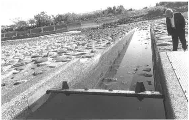
山田堰の土砂吐き（余水吐き）
