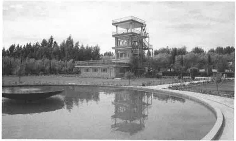
ガンベリ沙漠に建設したPMS農業事務所。職員と地域の作業員、そして無数の協力によって造られた（2016年3月17日）
