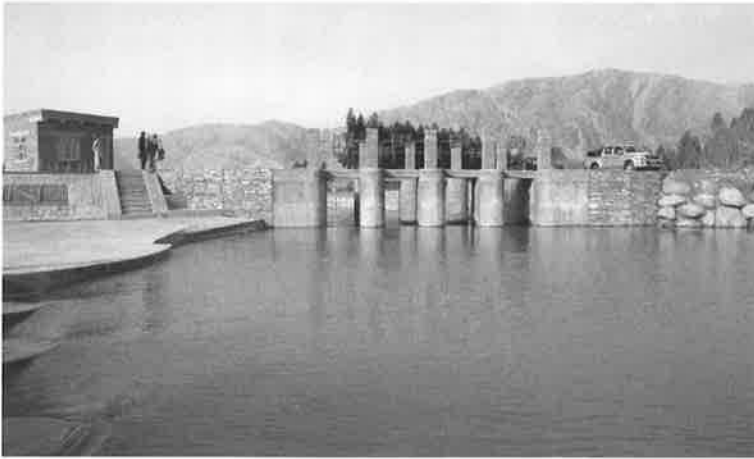
完成したミラーン取水口。水量は豊富に取れ、予定の1100ヘクタール以上を潤せる（2016年2月）
