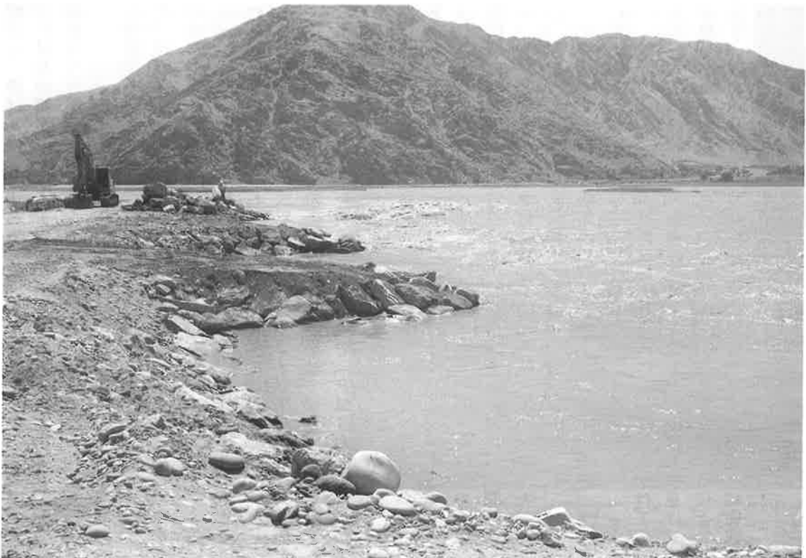
増水したクナル河。ミラーン堰上流対岸では必死の護岸堤の高上げ工事が続けられている（2016年6月20日）
