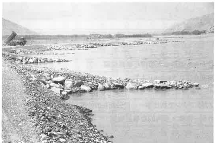
クナル河左岸（ミラーン堰上流対岸）の洪水流入路の護岸堤2.4km。今秋この上流にマルワリード第二堰の建設が開始される
