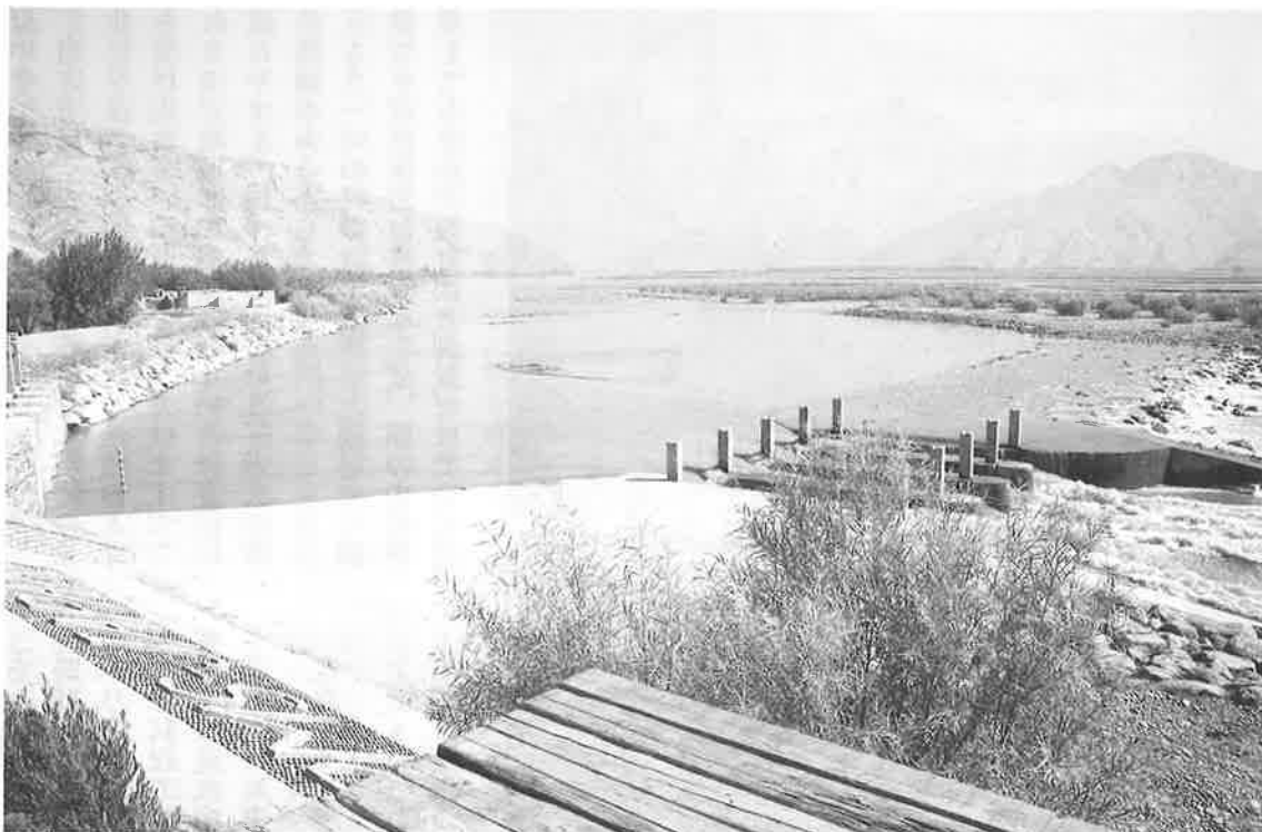
ひと夏の洪水を経たミラーン堰。堰や河道、砂州の観察後、秋より改修工事が開始される（2016年8月30日）
