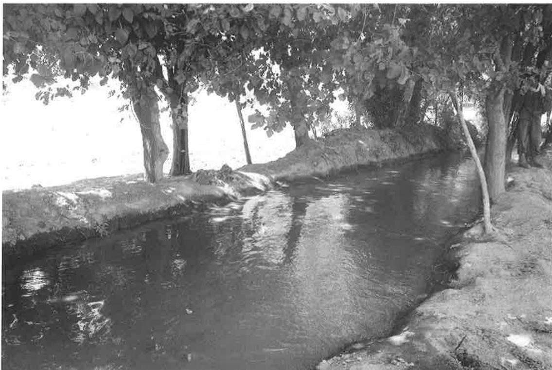
カシコート既存水路。堰からの取水可能量に対して既存水路の容量は半分以下。外壁の傾斜が急で幅も狭いので拡張工事により容量が増大し、飛躍的に農業生産は上がる（2013年7月8日）
