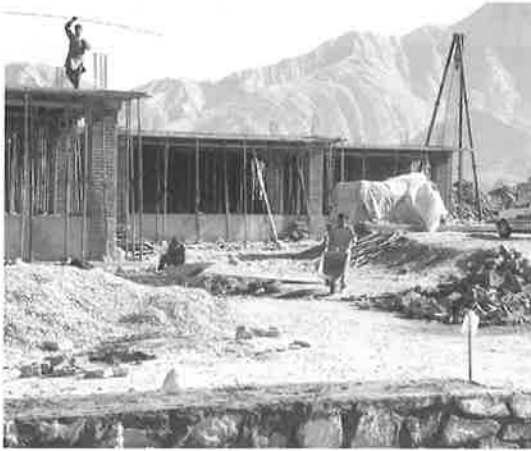
建設中の訓練所(2017年3月)
