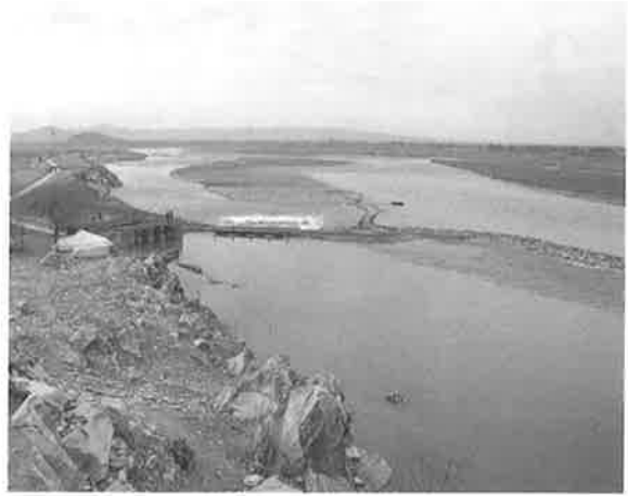
クナル河の本流。堰、取水門、主幹水路(画面左)が見える(2017年1月)
