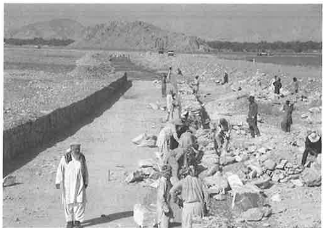
マルワリードⅡ用水路壁の蛇籠工に取り組みヤールモハマッド監督（左）率いる作業員たち（2017年6月1日）
