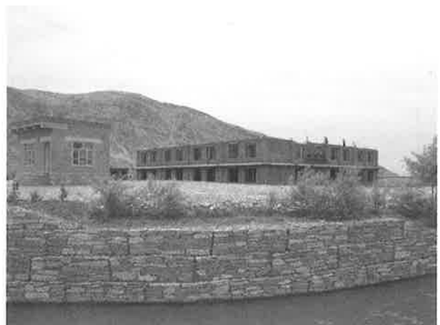
ミラーン堰近くに建設中の訓練所（2017年4月26日）
