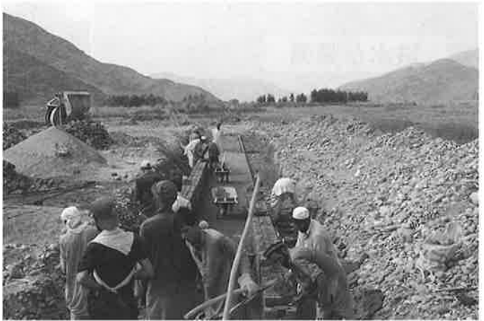
マルワリードⅡ用水路から送水されるカチャラⅡ分水路建設 (2017年8月13日)
