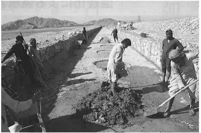
マルワリードⅡ用水路底にソイルセメントを敷く職員と作業員たち (2017年9月17日)
