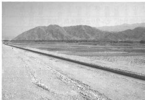
マルワリードⅡ用水路調節池ⅠからⅡ池までの主幹水路。通水後でも蛇籠2段目を積む作業や柳の挿し木は出来る。早期の灌漑を必要としているため用水路工事は下流域へと進行中(2017年9月26日)
