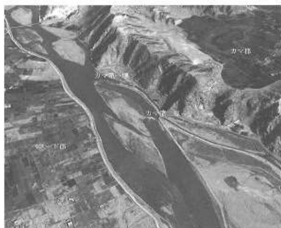
カマ第1堰、第2堰の位置
